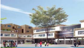
Collège Aulnay-sous-Bois, © Atelier BW Barbara
